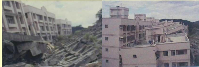
圖 2：民國 86 年 8 月溫妮颱風侵襲台灣，林肯大郡損壞情形。
